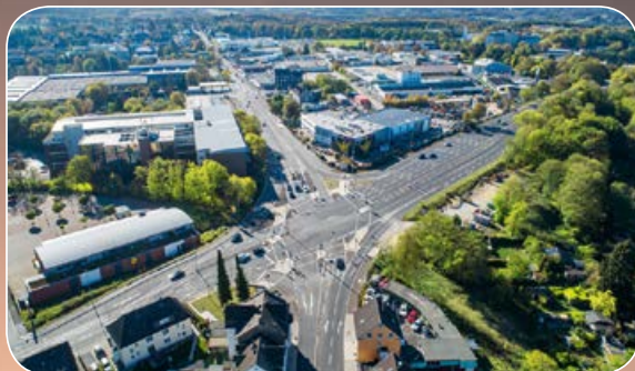
Umbau Straßenkreuzung Trecknase B 229 / B 51
